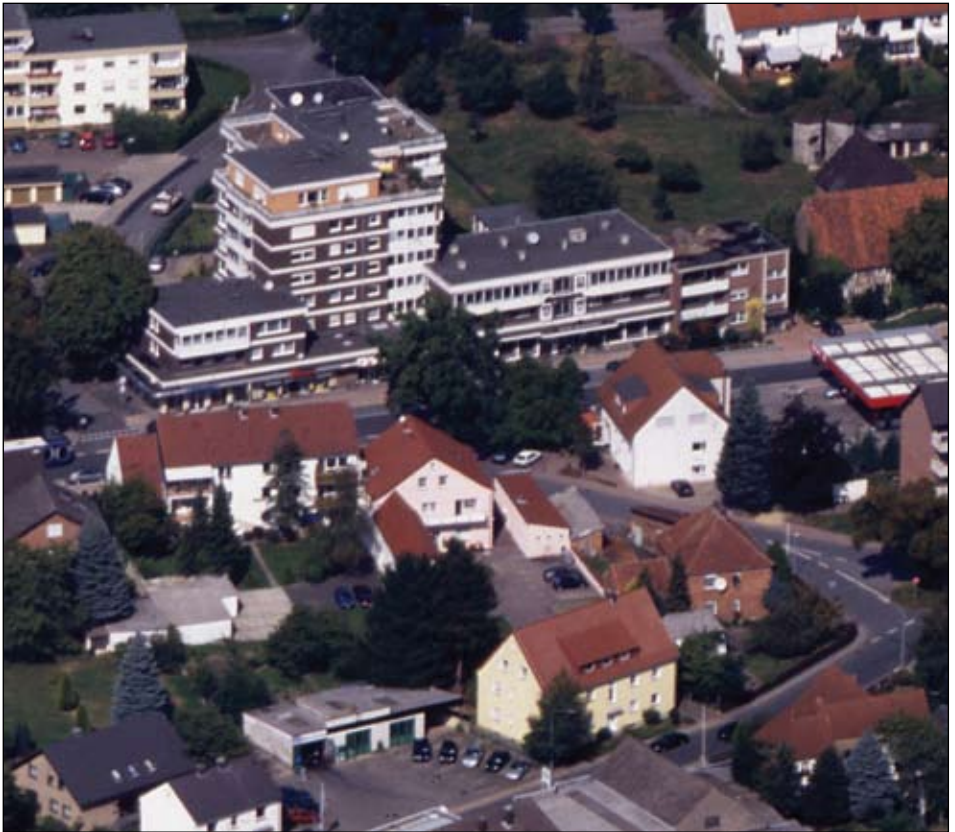
Ausschnitt: Von-Ketteler-Straße – Verbindungsstraße zur Urbanstraße – Urbanstraße mit Teil des Lindenplatzes, Haus Kürpick, Urbanstraße 8, Haus Gehrken. Von-Ketteler-Straße 19 a und 19. Foto: Stadtarchiv Paderborn/Stuttgarter Luftbild Elsässer, 5.9.2003.
